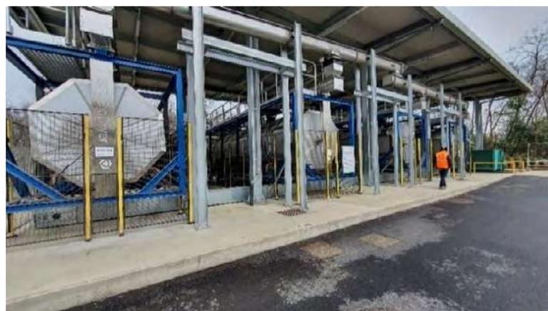
**Il bio essiccamento, infatti, sfrutta la capacità naturale del fango di autoprodurre una buona parte del calore necessario al processo di essiccamento.** Il processo avviene in reattori chiusi e a tenuta ermetica, dove il calore dell'aria esausta viene riutilizzato in scambiatori di calore interni, necessitando pertanto di un minor apporto di calore e quindi di minori consumi energetici.
