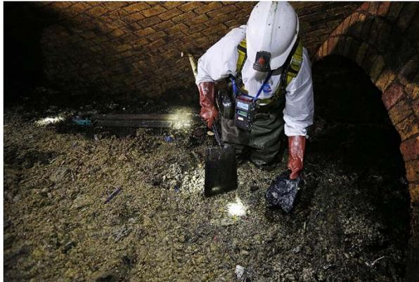
Le condotte con diametri nominali  $>DN 800$  sono sovente caratterizzate da un'inclinazione troppo bassa e quindi spesso causano depositi in dipendenza dalla consistenza delle acque di scarico e dalle variazioni di scarico.
