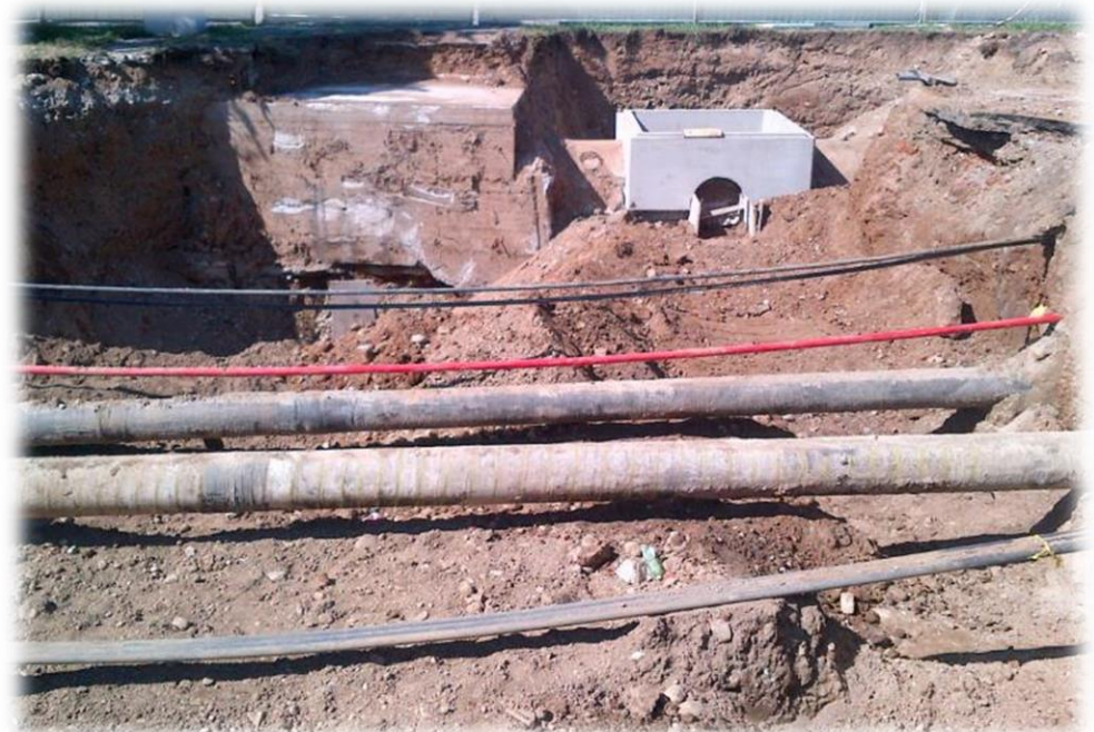
Esempio di sottoservizi interferenti
