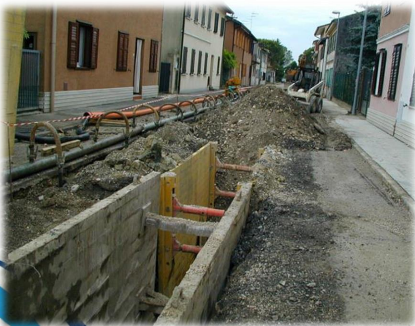
Esempio di scavo a cielo aperto
